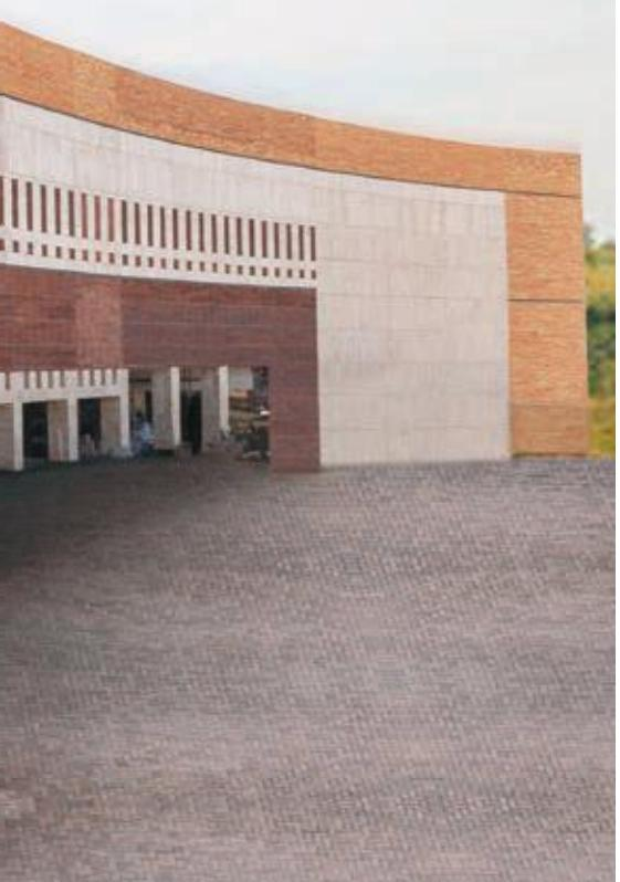
آجرهای شاموتی به دلیل استفاده از مواد اولیه بسیار مرغوب و فرایند شاموت سازی و پخت در دمای بالا دارای استحکام فشاری سیار زیاد و همچنین درصد نمک‌های محلول بسیار پایین و دارای ویژگی مقاومت در برابر یخ‌زدگی خوبی می‌باشد، این نوع آجر به دلیل خصوصیات ذکر شده قابل مقایسه با هیچ نوعی از آجرهای ساختمانی نبوده و دارای رنگ منحصر بفرد و کیفیت بی‌نظیری می‌باشد که در دو طیف رنگی زرد کم رنگ و پرتفالی رنگ تولید می‌شود.
